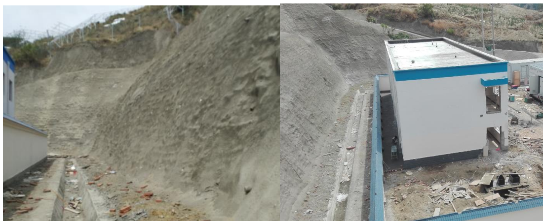
图 3-1 开关站开挖面
