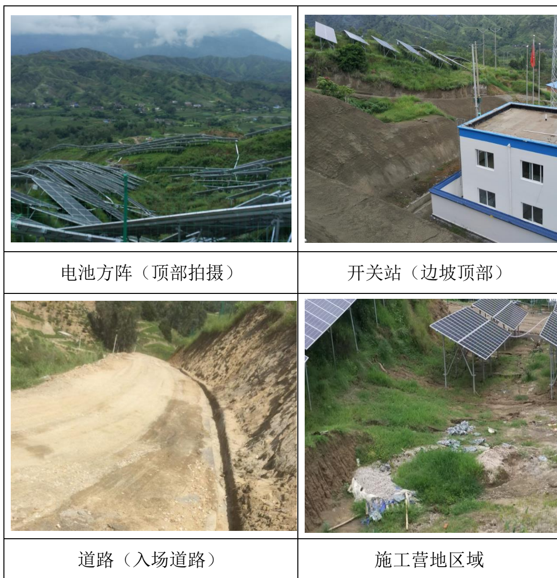
图 1-2 项目现场情况
