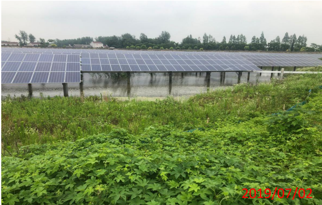
图 4-1 渔光阵列区植物措施
